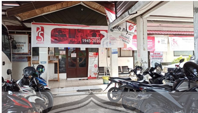
Gedung Unit Transfusi Darah
