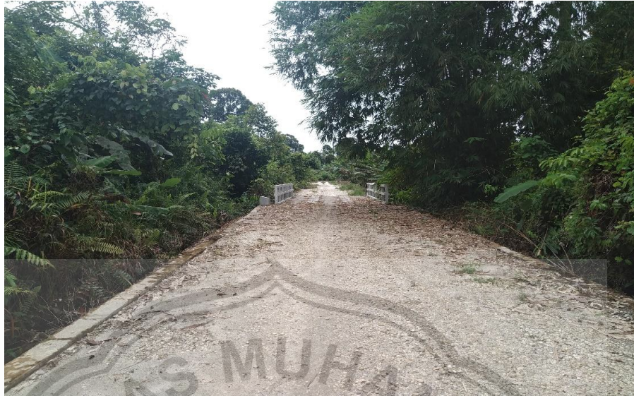
Gambar. 3. INFRASTRUKTUR JALAN DAN JEMBATAN
