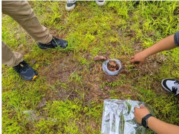
Gambar 4.3. Proses memasukkan sampah organik ke dalam lubang Resapan Biopori
